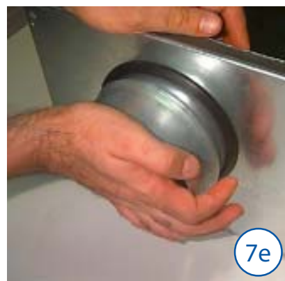
7e - Tegye be a csatlakozó idomot a csonkba. Szappanos vizet használjon, ha nem tudja benyomni.
